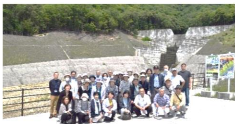
被害の跡が残る場所にある砂防堰堤
